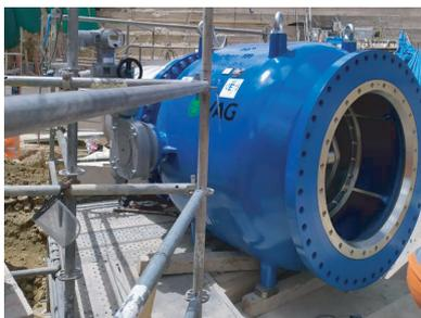
Minera Quellaveco - Suministro e Instalacion de 05 Válvulas de Paso Anular en Represa Vizcachas - Moquegua, Perú (DN1200 Pn16 el Más Grande Instalado en Perú)
